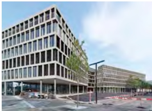
Der Neubau besetzt ein ehemaliges Fabrikareal zwischen dem Bahnhof Brugg und dem Hauptbau von Fritz Haller, ganz rechts im Hintergrund. Bild: René Röhli
