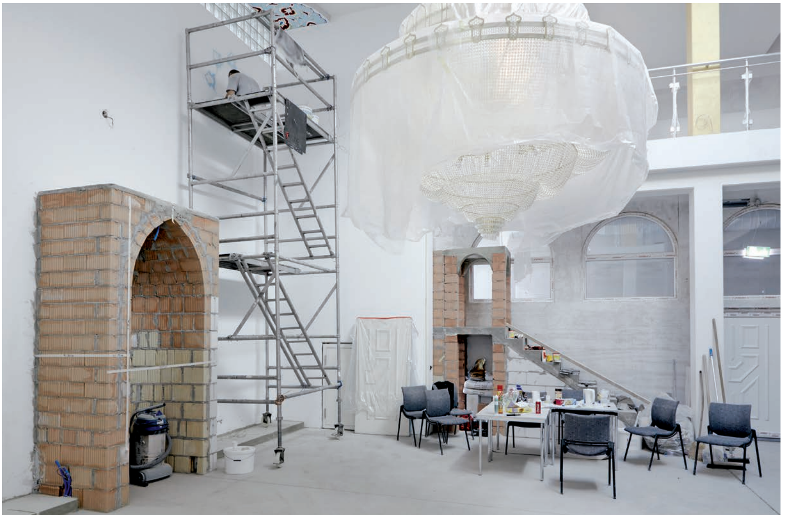
Die Muslime bauten ihre Moschee in Fronarbeit in der Freizeit. Sie bestellten Plastikfenster aus Mazedonien und mauerten mit handelsüblichem Backstein.
