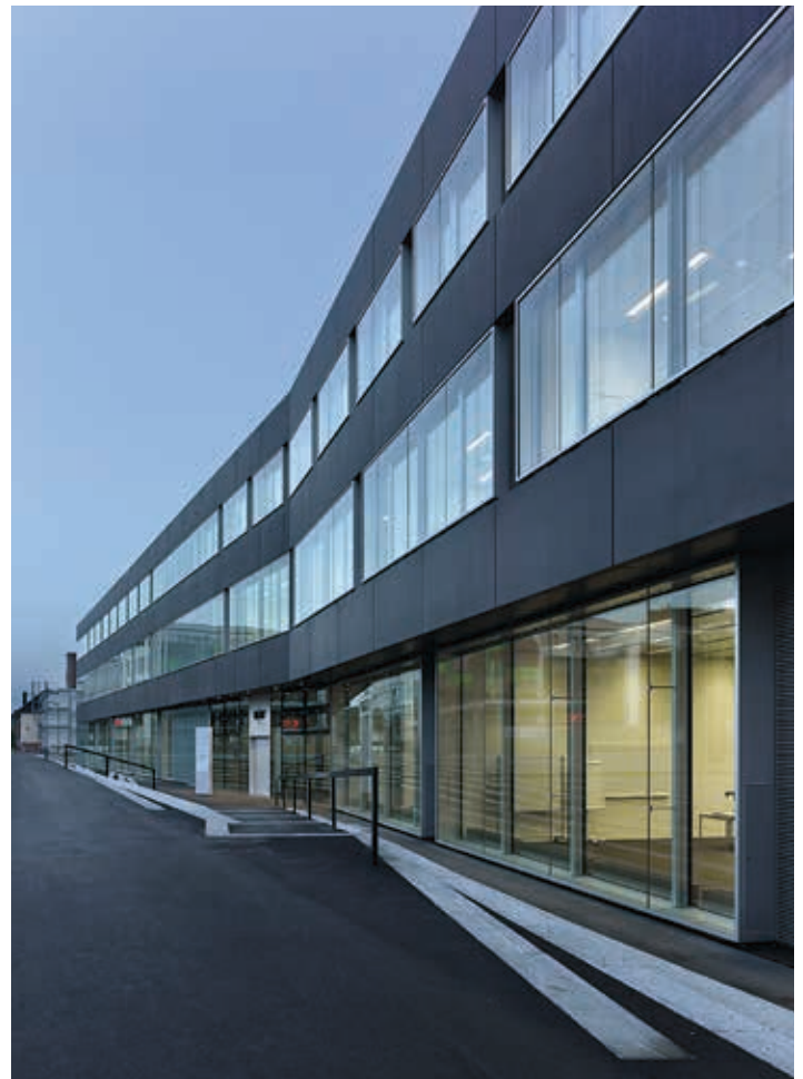
Abbildung 67: FHNW Olten – Fassadenansicht (Foto: Alexander Gempeler).
