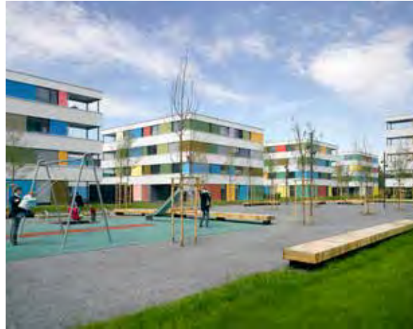
QUARTIER « IM VIERI », SCHWERZENBACH | QUARTIER « IM VIERI », SCHWERZENBACH © JOHANNES MARBURG
