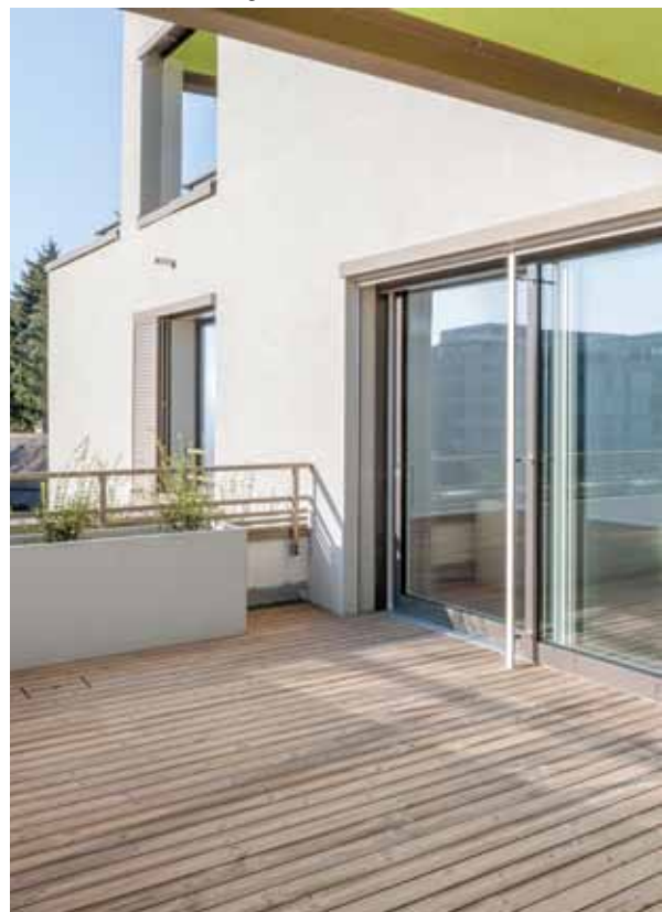
Mit den Pflanzkästen auf den Terrassen soll die Fassade begrünt werden.
