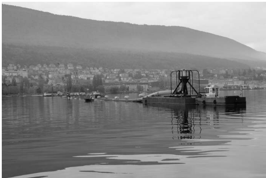
Figure 6 : Mise en place de la conduite sous-lacustre et de la crépine du réseau d'eau du lac utilisé pour le rafraîchissement écologique des bâtiments du quartier, dont Microcity. (photo : Viteos SA)
